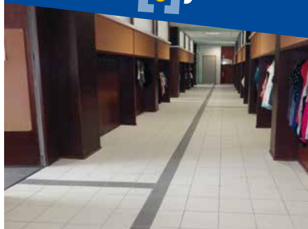
Val Ronzière : sol pvc remplacé par du carrelage
